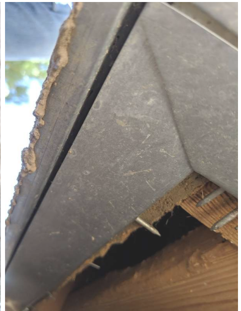
Bottom edge of stucco
