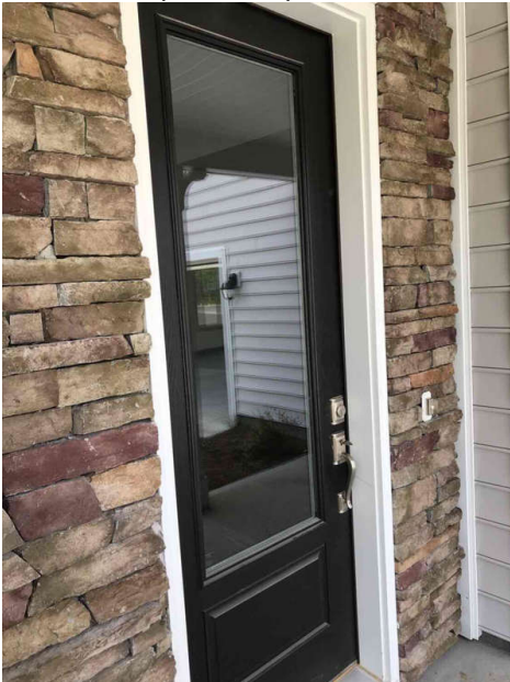
Front door overview
