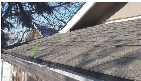
Drip edge flashing
