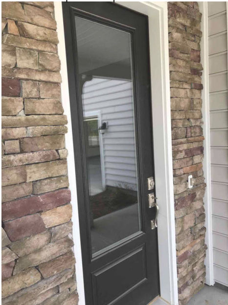
Front door overview
